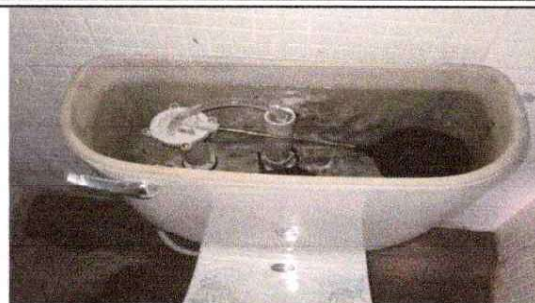
FOTO 2: Sustitución de accesorios inodoro (contra llave, tubo de abasto y tanque)
