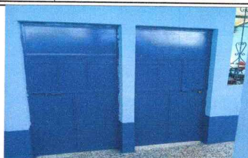
FOTO 8: Mantenimiento a estructura (lijado, cambio de tubo, cepillado, sujeciones, aplicación de pintura) PUERTA EN AULA
