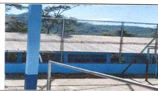
FOTO 12: Reparación de tubo hg y malla galvanizada EN PATIO
