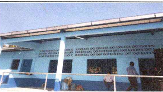
FOTO 6: Sustitución de canal de metal Y Reparación de bajada de agua pluvial, tubo PVC 3" EN MODULO DE AULAS
