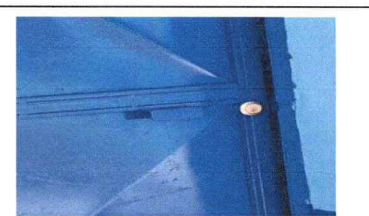
FOTO 4: Sustitución de chapa EN COCINA
