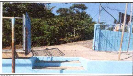
FOTO 11: Mantenimiento a portones de metal de rejas EN PATIO
