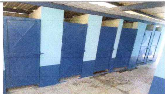
FOTO 1: Mantenimiento a estructura (lijado, cambio de tubo, cepillado, sujeciones, aplicación de pintura) a puertas servicios sanitarios
