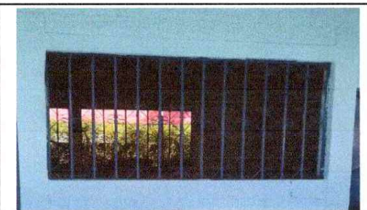
FOTO 5: Mantenimiento a balcones de metal. EN COCINA
