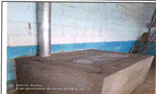
FOTO 7: Sustitución de estufa rural (completa) incluye chimenea y plancha de metal EN COCINA
